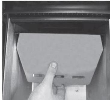
Fig. 16: rotación de la placa cortafuego
