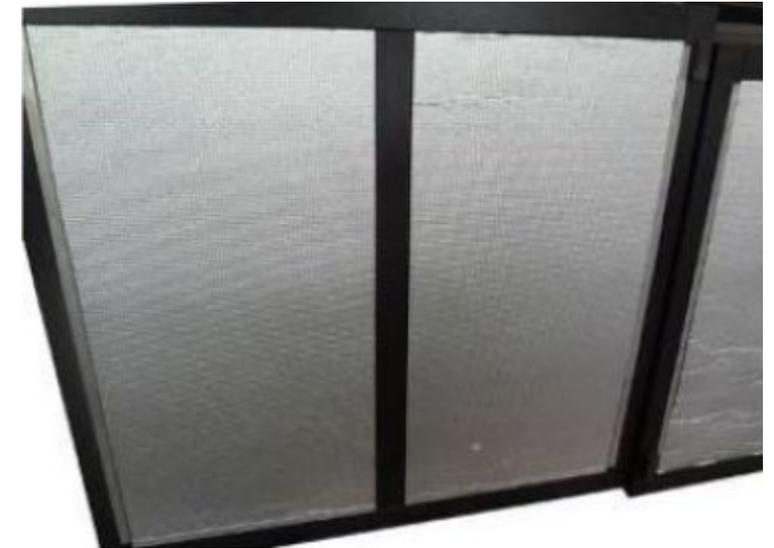
Aislamiento en el panel del faldón mediante espuma de 15 mm.
